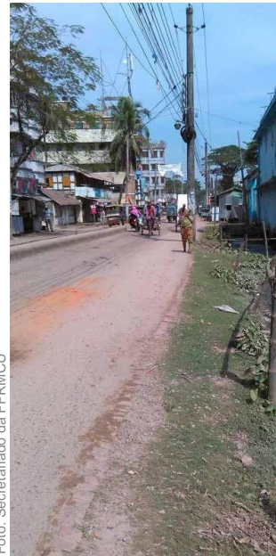
Abrir esgoto ao lado da estrada em Patuakhali, Bangladesh Figure.
